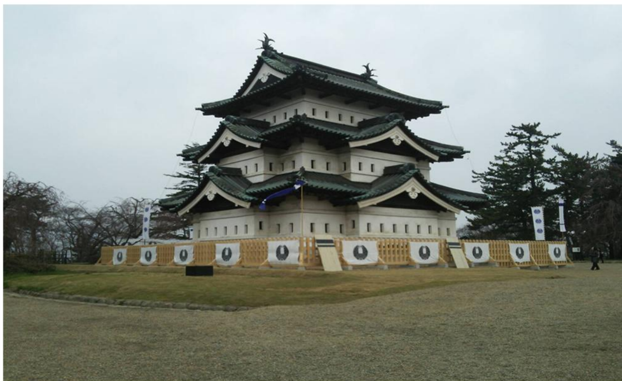
(写真：弘前城曳家後)
